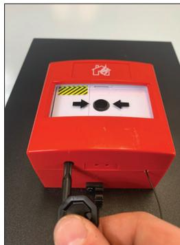
ABBILDUNG 9: RÜCKSETZEN DER DRUCK-RUFSÄULE
